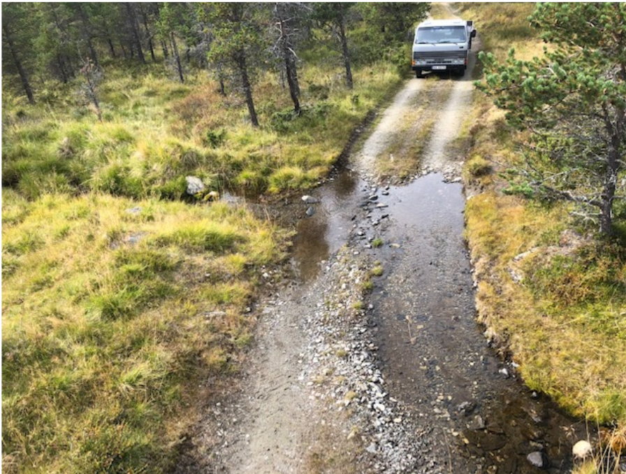
Figur 5 og 6. Traktorveg vises med lavbrekk ved krysningspunkt med bekken. Kilde: Furuhovde privat, 6.09.2021.
