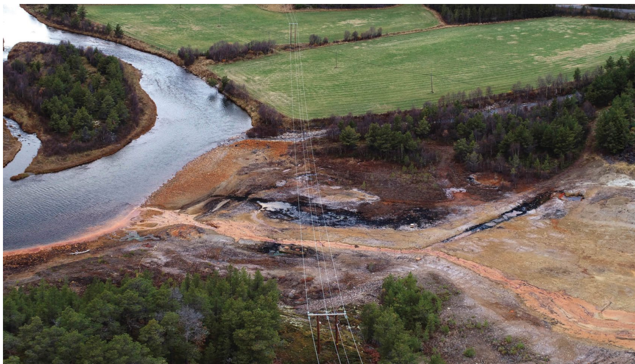
Figur 5-1: Utløpet av bekk som transporterer avrenning fra gruveområdet til Folla. (Asplan Viak, 2020)
