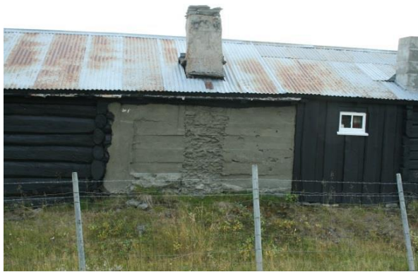
Bilde: Kvitdalen, skålvegg i betong.
