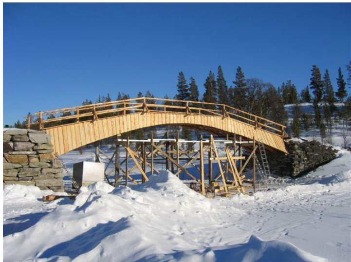
Restaureringsprosjekt gamle Grimsa bru
