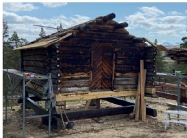
SMIL prosjekt med restaurering av stabbur på Holen
