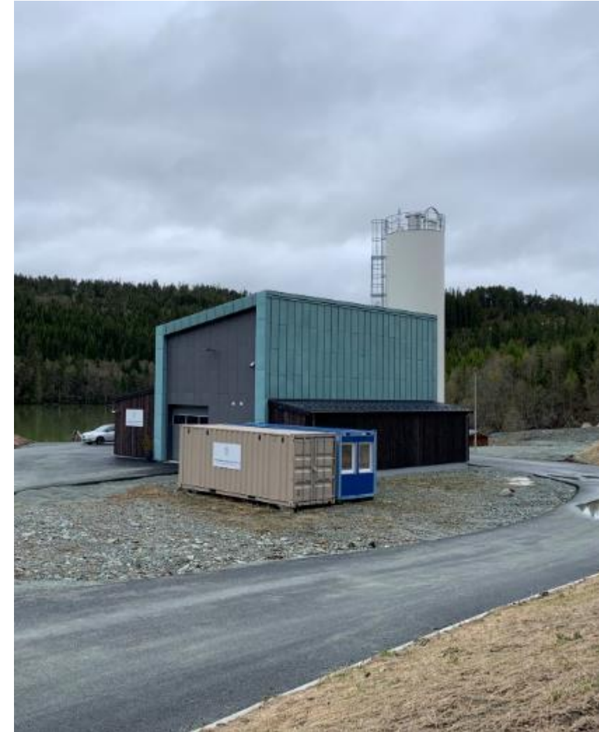
Renseanlegget ved Løkken gruve
